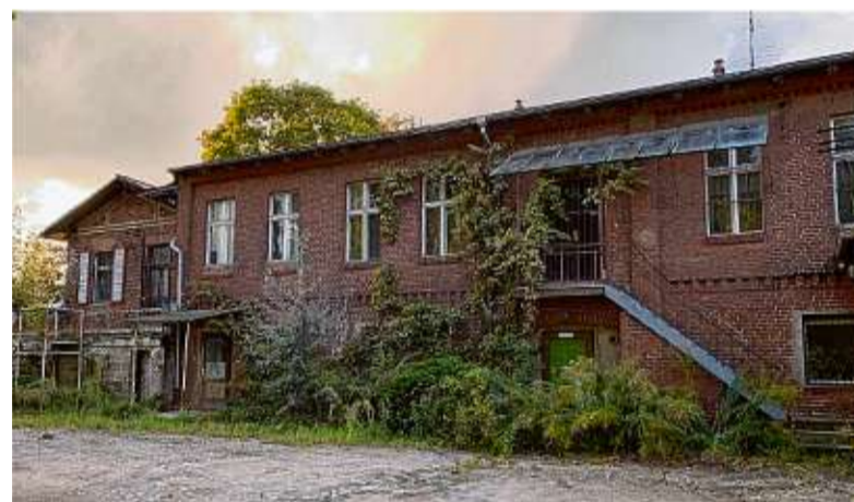
Die ehemalige Schönbecksche Brauerei an der Wittstocker Allee in Neuruppin, die zuletzt den Fruchthof beherbergte, soll aus dem Dornröschenschlaf erwachen. Nun wurden erstmals konkrete Pläne dafür vorgestellt. Foto: Luisa Krsynowski
