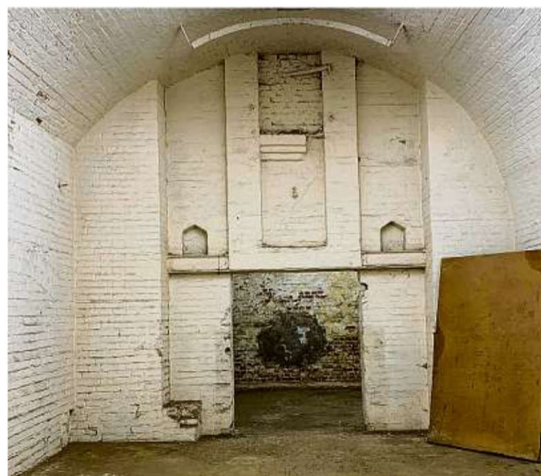
Im Eiskeller der ehemaligen Schönbeckschen Brauerei in Neuruppin soll es künftig Schulungen geben. Foto: Luisa Krsynowski
